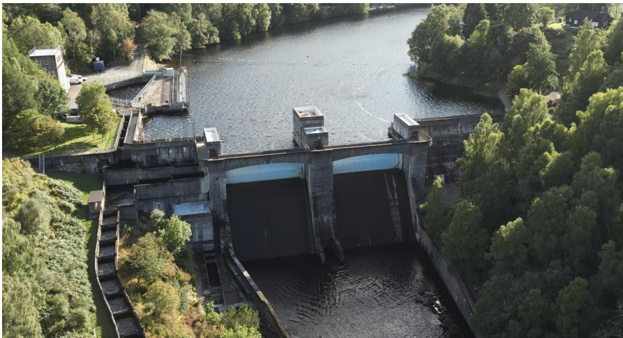
Clunie Dam in Schottland, digital inspiziert mit Hilfe von STRUCINSPECT. © STRUCINSPECT
