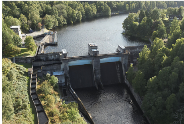
3D-Modell des Clunie Damms Digitale Inspektion: Das Wasserkraftwerk Clunie im Infrastructure Lifecycle Hub
