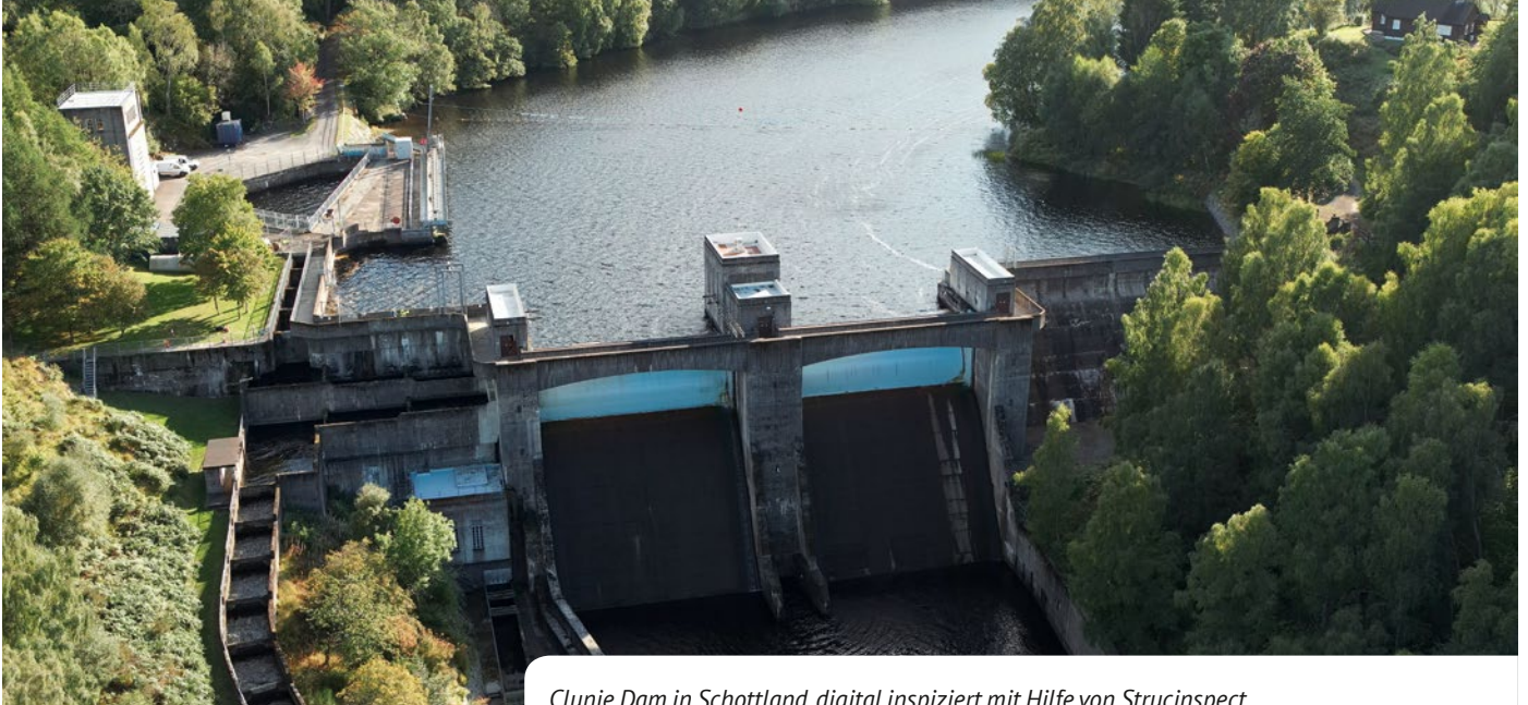
Clunie Dam in Schottland, digital inspiziert mit Hilfe von Strucinspect.
